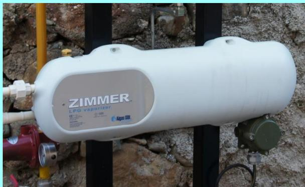
Le vaporiseur ZIMMER est la solution fiable et économique qu'il soit associé à un réservoir de GPL aérien ou enterré. Il permet un gain de place et l'assurance d'une alimentation constante en gaz quel que soit les conditions climatiques ou la faible capacité du stockage.
